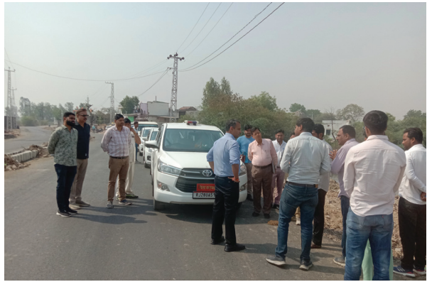
ब्रिज निर्माण कार्यों की स्थिति का जायजा लेकर यह सुनिश्चित करने के निर्देश दिए कि निर्माण कार्य तय समय सीमा में पूरा हों। उन्होंने सुरक्षा मानकों का ध्यान रखते हुए निर्माण स्थलों पर मजदूरों
